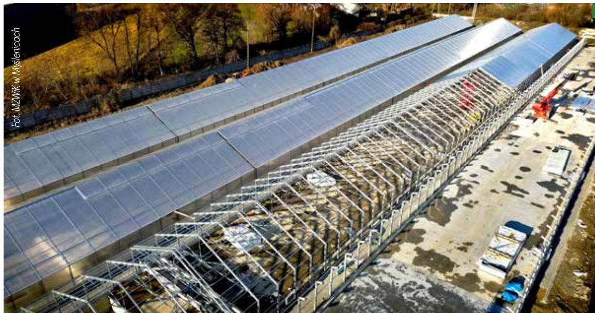
HALE SUSZARNI SŁONECZNEJ OSADU o wymiarach 12,25 × 140 m. Konstrukcja stalowa ocynkowana z pokryciem z płyt poliwęglanowych
