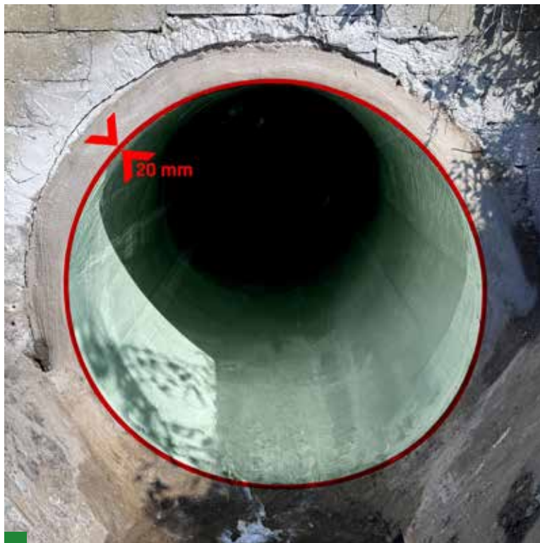
FOT. 3 Duże sztywności obwodowe pozwalają na naprawianie bardzo zdegradowanych kanałów, które utraciły już swoją statyczną wytrzymałość, poprzez instalowanie w nich metodą CIPP nowoczesnych rur kompozytowych, przejmujących na siebie naprężenia statyczne
