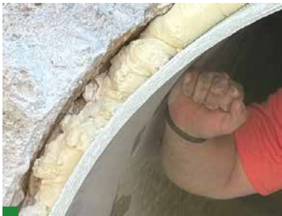
FOT. 1 Nowa rura, zainstalowana z wykorzystaniem tej istniejącej w ziemi rury jako formy
