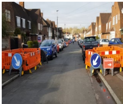
1. Dwa niewielkie wykopy
