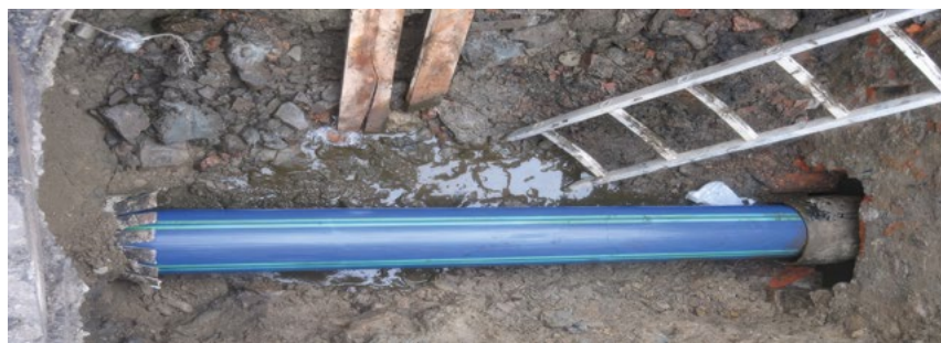
FOT. 5. | Relining rurą PERC bez wypełnienia
