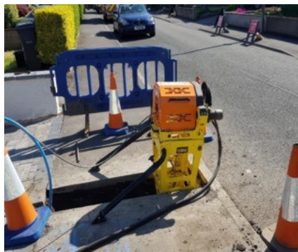
4. Zamontuj wyciągarkę w wykopie i ciągnij
