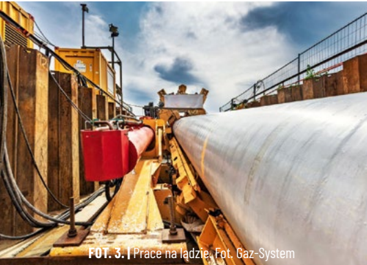
FOT. 2. | Prace na lądzie. Fot. Gaz-System
