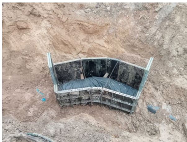
FOT. 3. | Szalunek opaski betonowej łuku segmentowego gotowy do zalania betonem
