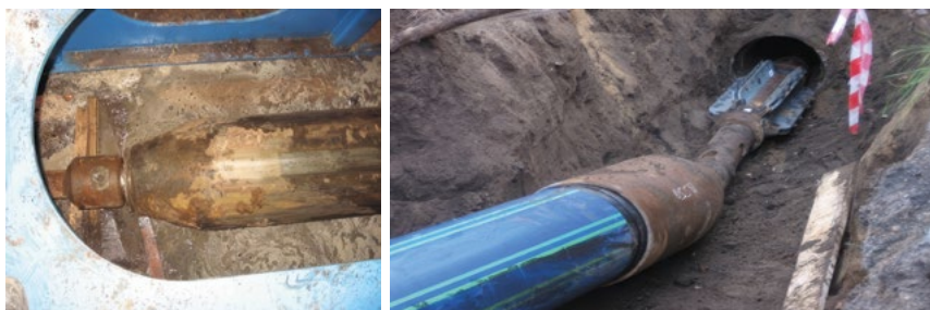
FOT. 10. | Głowica do rozcinania rur PE RC
