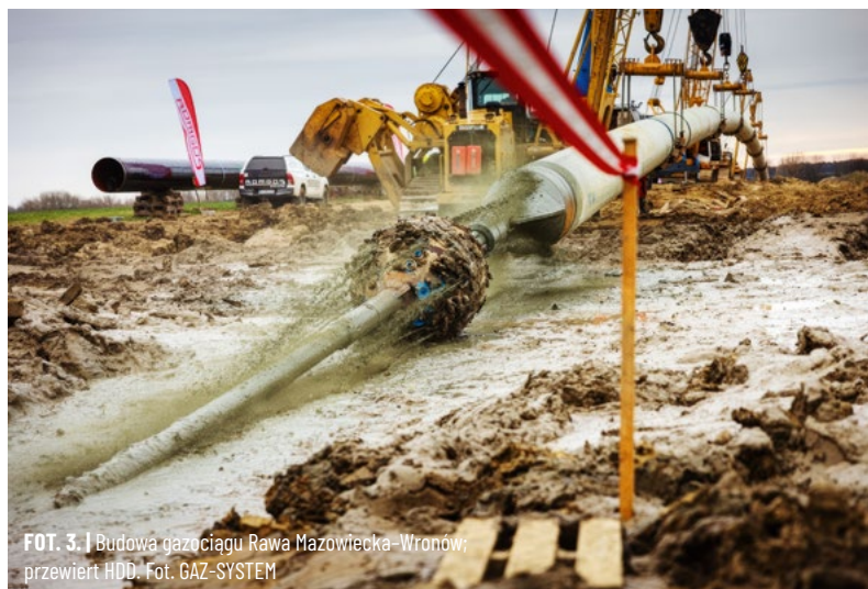
FOT. 2. | Budowa gazociągu Oświęcim–Tworzeń; przewiert Direct Pipe. Fot. GAZ-SYSTEM
