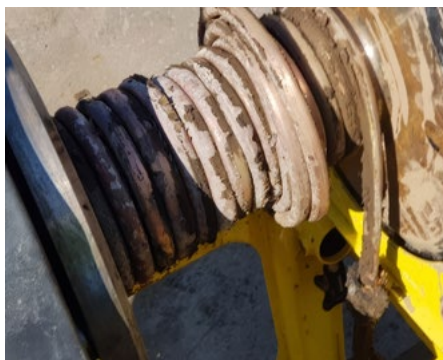
5. Stara rura usunięta z gruntu
