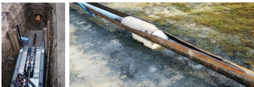
FOT. 9. | Wciągarka hydrauliczna wraz ze stacją napędową i rozcinana rura stalowa
