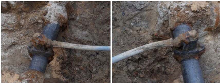
FOT. 4. | Przykład przyłącza ołowianego, metoda wykopowa
