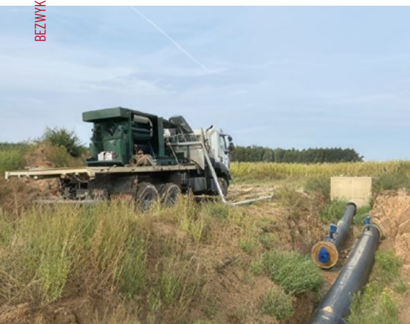
FOT. 1. | Zbudowana na podwoziu samochodu ciężarowego pompa wysokociśnieniowa z napędem spalinowym wykorzystywana do podnoszenia ciśnienia wody podczas prób szczelności rurociągu
