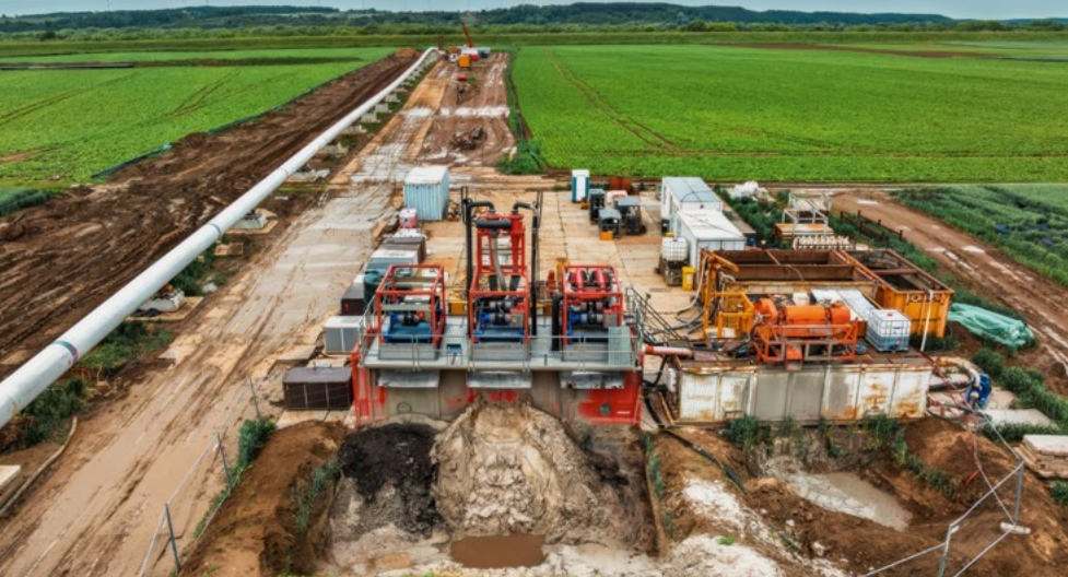
FOT.5. | Projekt FSRU – budowa części lądowej. Fot. GAZ-SYSTEM
