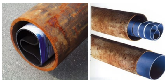
FOT. 6. | Rura zdeformowana i po zakończeniu procesu renowacji
