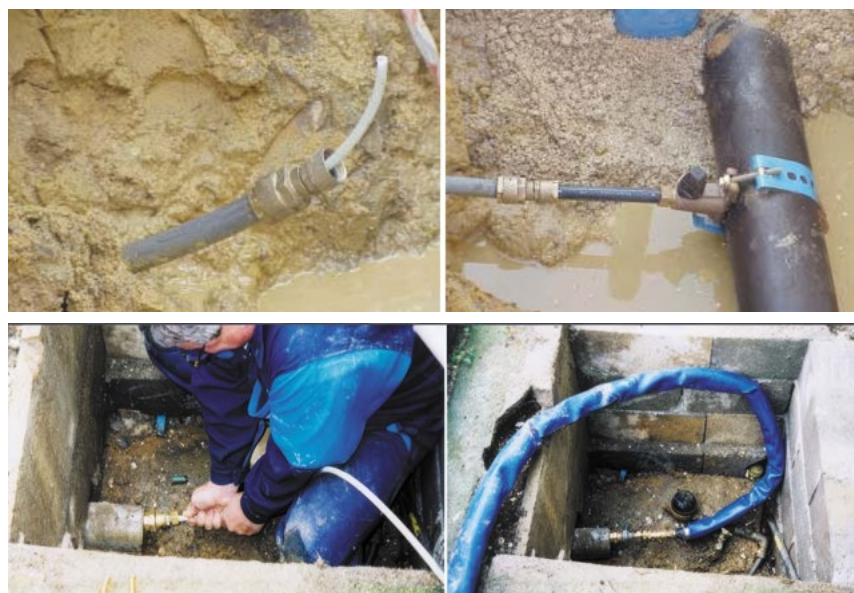
FOT. 8. | Wciąganie rury PET i rewersja pod wpływem gorącej wody i sprężonego powietrza
